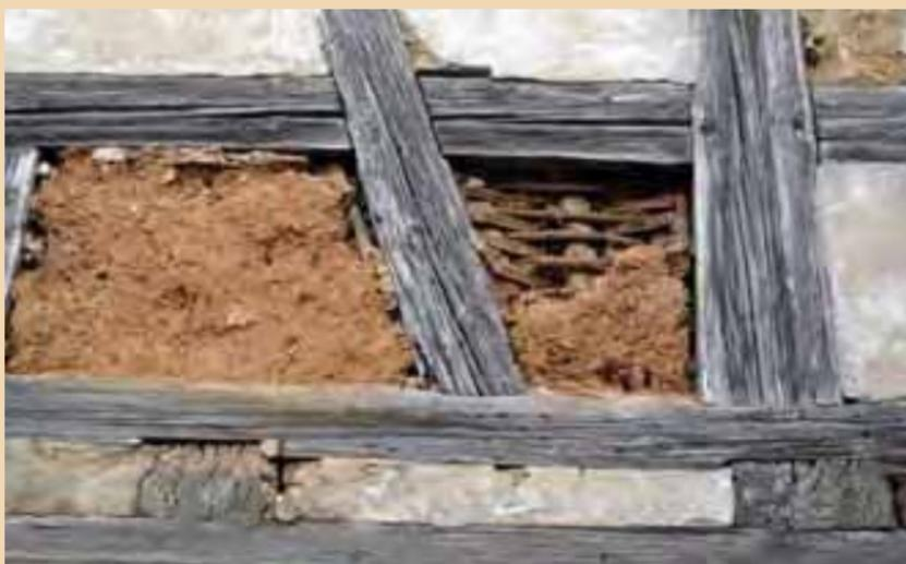
Häuser aus Fachwerk haben ein tragendes Gerüst aus Holz. Die Zwischenräume – die sogenannten Gefache – können, wie bei einigen Häusern beschrieben, mit unterschiedlichen Materialien ausgefüllt werden. Die vertikalen Elemente werden
