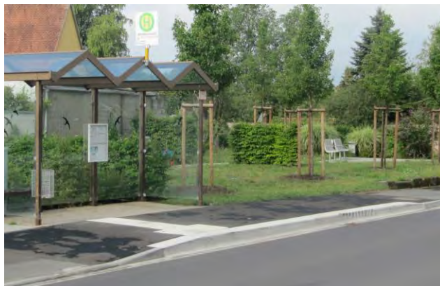
Abb. 8: Haltestelle Mönchherrnsdorf, Lkr. Bamberg Mit vergleichsweise einfachen Mitteln zu bewältigender Umbau zu einer barrierefreien Haltestelle am Straßenrand: 18 cm hohes Sonderbord auf einer Länge von ca. 9 m (Tür 1 und Tür 2 eines 12 m-Busses sind damit barrierefrei); Haltestellentiefe von ca. 2,50 m; das helle Bord hebt sich gut vom dunklen Belag von Fahrbahn und Gehsteig ab.
