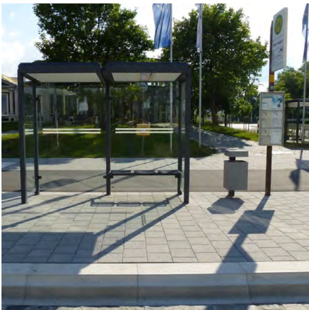
Abb. 32: Haltestelle Stein Palm Beach, Lkr. Fürth Fahrgastunterstand mit einsehbarem und ausreichend dimensionierten Wartebereich, der eine gute Aufenthaltsqualität vermittelt.
