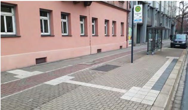
Abb. 26: Haltestelle Gostenhof Ost, Nürnberg Flächen mit Bodenindikatoren gelten für blinde und sehbehinderte Menschen als sichere Bewegungs- und Aufenthaltsbereiche. Daher dürfen auf Flächen wie z. B. Radwegen keine taktilen Bodenindikatoren verlegt werden. Der Auffindestreifen wird an obiger Haltestelle daher durch den querenden Radweg unterbrochen. Der Radweg verläuft hinter dem Fahrgastunterstand. Aufgrund einer Vorgabe der Stadt Nürnberg befindet sich auch an Tür 2 ein zweites Einstiegsfeld, welches durch einen Leitstreifen mit dem Einstiegsfeld an Tür 1 verbunden ist. Zwischen Leitstreifen und Sonderbord wurden dunkle Platten verlegt (Kontraststreifen).
