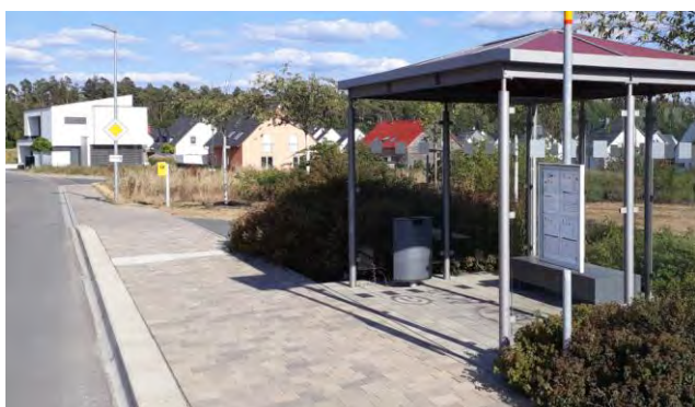
Abb. 20: Haltestelle Egersdorf Nord, Lkr. Fürth Die Manövrierfläche für Rollstuhlfahrer ist sowohl auf Höhe Tür 1, als auch auf Höhe der wichtigeren Tür 2 ausreichend vorhanden.
