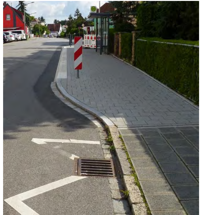
Abb. 7: Die Haltestelle Stein Sommerstraße im Landkreis Fürth wurde von einer nicht barrierefreien Haltestelle am Fahrbahnrand zu einer vollständig barrierefreien Kaphaltestelle umgebaut. Die Gehwegbreite wurde dazu auf einer Länge von rund 15 Meter von 1,90 m auf 2,80 m vergrößert. Die Warte- und Rangierfläche ist nun ausreichend breit und das Hochbord kann parallel und spaltminimierend angefahren werden. In beiden Fahrtrichtungen ist das Kap durch Leitbaken abgesichert. Im Straßenverlauf befinden sich vor der Haltestelle Längsparkstreifen.
