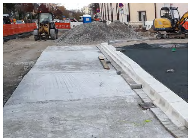
Abb. 19: Haltestelle Wiesenstraße, Fürth Entstehung einer festen, verformungsfreien Fahrspur durch den Einbau von Betonplatten im Haltestellenbereich im Zuge des barrierefreien Umbaus; anschließend wird die Asphaltenschicht aufgetragen.
