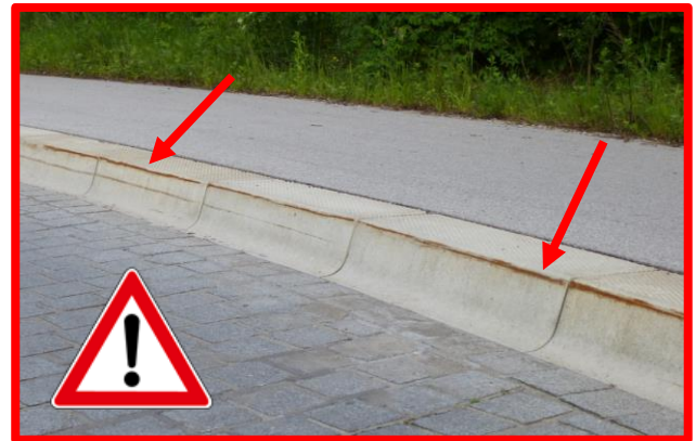
Abb. 12: Aufgrund des bereits im Anfahrtsbereich 18 cm hohen Sonderbords setzt bei nahem, spaltminimierendem Anfahren die Karosserie auf, erkennbar an den braunen Schleifspuren am Bordstein (vgl. Pfeile). Daher müssen immer die Schleppkurve der Busse und der Überhang vor der ersten Achse mitberücksichtigt werden.
