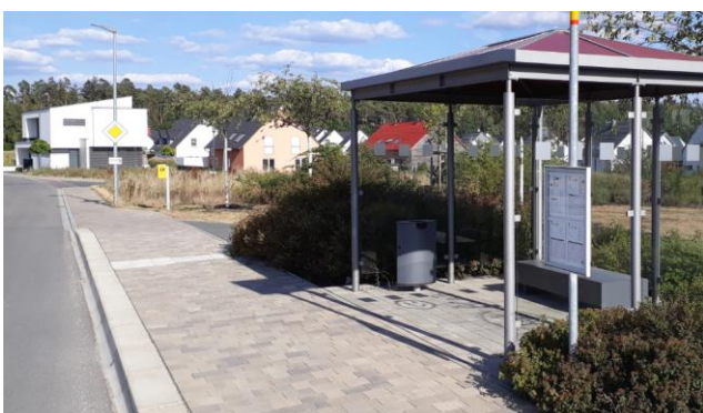
Abb. 20: Haltestelle Egersdorf Nord, Lkr. Fürth Die Manövrierfläche für Rollstuhlfahrer ist sowohl auf Höhe Tür 1, als auch auf Höhe der wichtigeren Tür 2 ausreichend vorhanden.
