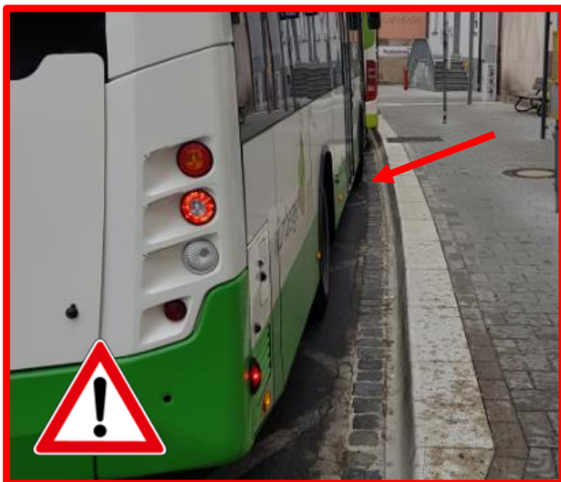
Abb. 11: Gefährlicher Abstand zwischen Bord und Tür 2 des Fahrzeugs, insbesondere für mobilitätseingeschränkte Personen. Aufgrund einer zu eng dimensionierten Schleppkurve kann zwar der vordere Bus das 16 cm-Hochbord spaltmindernd anfahren. Die Haltestelle wird jedoch häufig von zwei Bussen gleichzeitig bedient (inkl. Wartezeiten).
