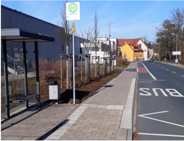
Abb. 17: Haltestelle Stein Forum, Lkr. Fürth Haltestelle am Fahrbahnrand mit 24 cm hohem Sonderbord mit Spurführung. Durch den Radfahrstreifen im Anfahrsbereich der Haltestelle gilt ein Halteverbot am Straßenrand. Es können also keine parkenden Autos die – schon weit vor der Haltestelle beginnende – gerade Anfahrt des Busses zum Haltestellenbord behindern.
