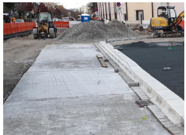
Abb.19: Haltestelle Wiesenstraße, Fürth Entstehung einer festen, verformungsfreien Fahrs pur durch den Einbau von Betonplatten im Haltestellenbereich im Zuge des barrierefreien Umbaus; anschließend wird die Asphaltschicht aufgetragen.
