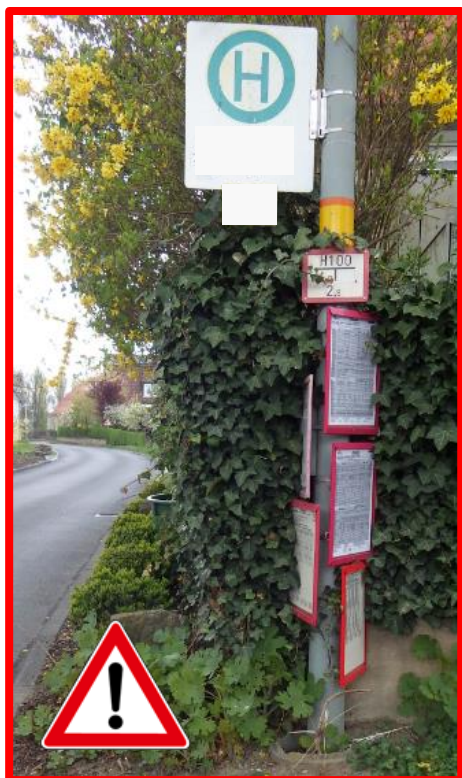
Abb. 34: Hier ist das Aufstellen eines separaten Mastes dringend erforderlich!
