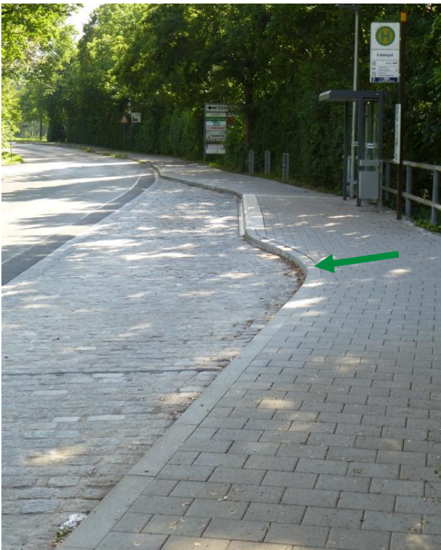
Abb. 18: Haltestelle Stein Fabergut, Lkr. Fürth Die Busbucht mit Nase ermöglicht eine parallele, spaltminimierende Anfahrt des Steiges. Auf Höhe der Einbuchtung (grüner Pfeil) ist der Gehsteig nur 12 cm hoch und kann dadurch leicht überstrichen werden. Im Bereich der 9 Meter langen Aufstellfläche wurde ein 22 cm hohes Sonderbord verbaut.
