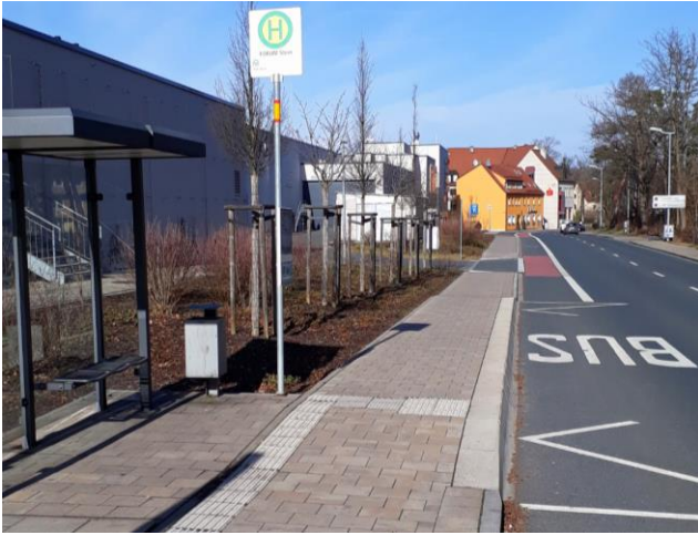
Abb. 17: Haltestelle Stein Forum, Lkr. Fürth Haltestelle am Fahrbahnrand mit 24 cm hohem Sonderbord mit Spurführung. Durch den Radfahrstreifen im Anfahrtsbereich der Haltestelle gilt ein Halteverbot am Straßenrand. Es können also keine parkenden Autos die – schon weit vor der Haltestelle beginnende – gerade Anfahrt des Busses zum Haltestellenbord behindern.
