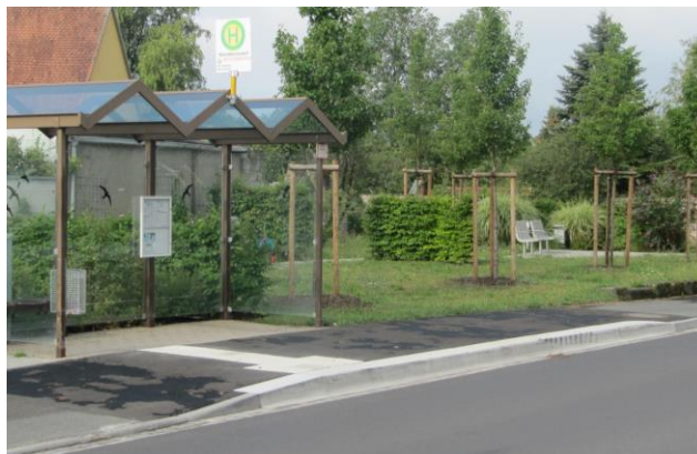
Abb. 8: Haltestelle Mönchherrnsdorf, Lkr. Bamberg Mit vergleichsweise einfachen Mitteln zu bewältigender Umbau zu einer barrierefreien Haltestelle am Straßenrand: 18 cm hohes Sonderbord auf einer Länge von ca. 9 m (Tür 1 und Tür 2 eines 12 m-Busses sind damit barrierefrei); Haltestellentiefe von ca. 2,50 m; das helle Bord hebt sich gut vom dunklen Belag von Fahrbahn und Gehsteig ab.
