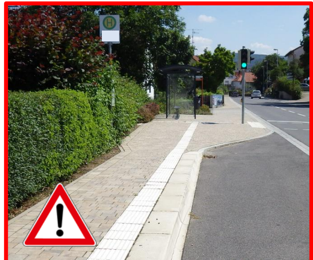
Abb. 28: Der Leitstreifen ist – von der Straßenquerung kommend – gefährlich nah an den Bordsteinrand gebaut worden. Zwischen Bordsteinkante und Leitstreifen muss ein Abstand von mindestens 60 cm vorgesehen werden.
