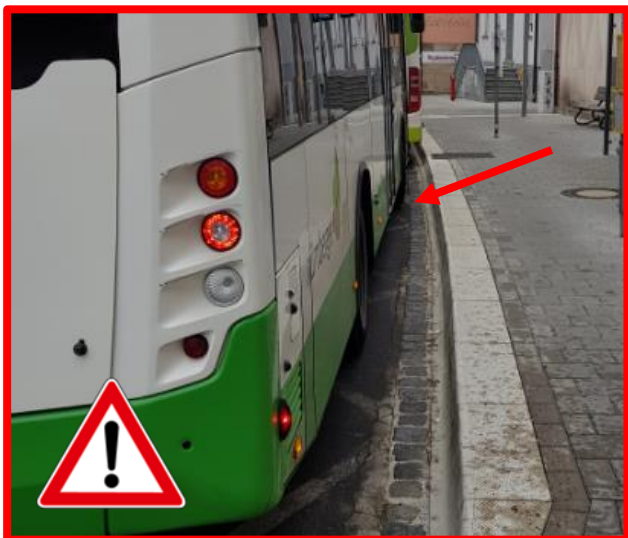
Abb. 11: Gefährlicher Abstand zwischen Bord und Tür 2 des Fahrzeugs, insbesondere für mobilitätseingeschränkte Personen. Aufgrund einer zu eng dimensionierten Schleppkurve kann zwar der vordere Bus das 16 cm-Hochbord spaltmindernd anfahren. Die Haltestelle wird jedoch häufig von zwei Bussen gleichzeitig bedient (inkl. Wartezeiten).
