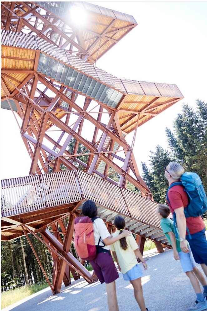
Hoch hinaus: Der Aussichtsturm am Pressecker Knock ist über 45 Meter hoch. (© VGN/A. Gaspar-Klein)
